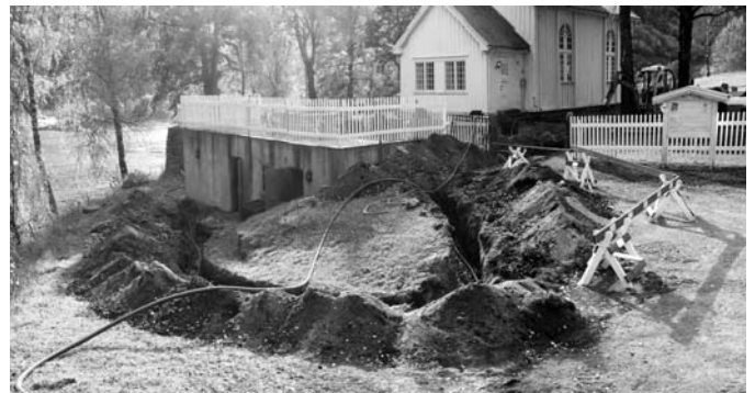
Høsten 2013 ble det lagt ny frostsikker vannledning til Mæl kyrkje. Kirkegårdsarbeiderene grave grøfter og la frostsikre rør for å ha vann hele vinteren. Vannet har frosset hver vinter i Mæl kyrkje, med de utfordringer det har medført.
