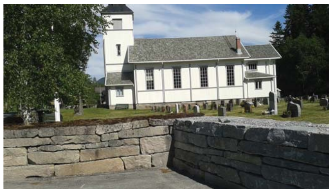
Fin sammenheng mellom den gamle og den nye kirkegårdsmuren
